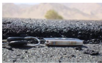
آسفالت الیافی-ضخامت: ۳سانتیمتر کارفرما: اداره راه یزد-مهر ۱۳۹۳ پیمانکار: حریتاش مسیر: انار-مهریز
